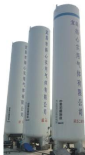
液态二氧化碳储罐 LCO 2 storage tank
